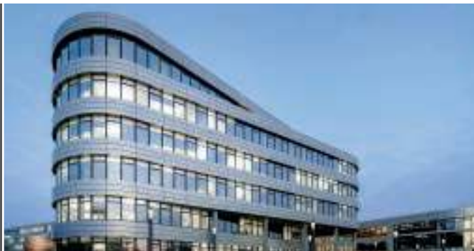
Дымоудаление RheinEnergie AG, Кёльн
