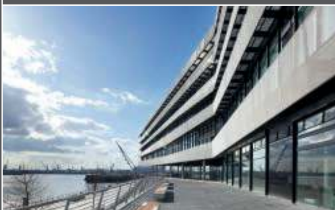
Устройство дымо- и теплоудаления с напряжением 230 В Университет Hafencity, Гамбург
