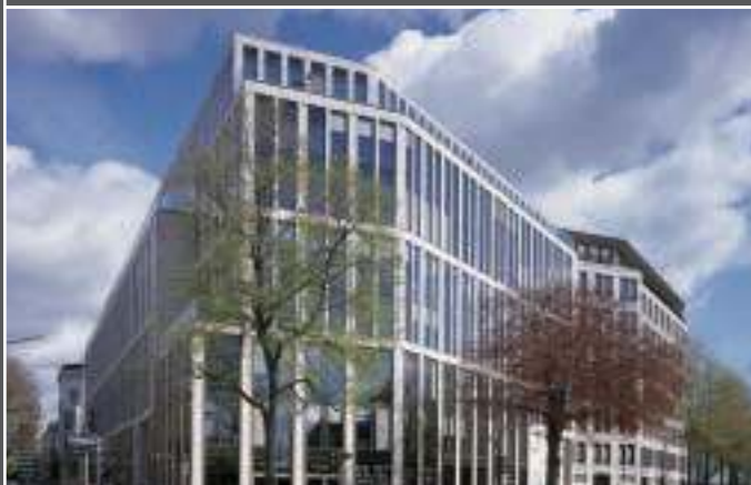
Дымоудаление из шахт лифтов Офисное здание на набережной Альстеруфер, Гамбург
